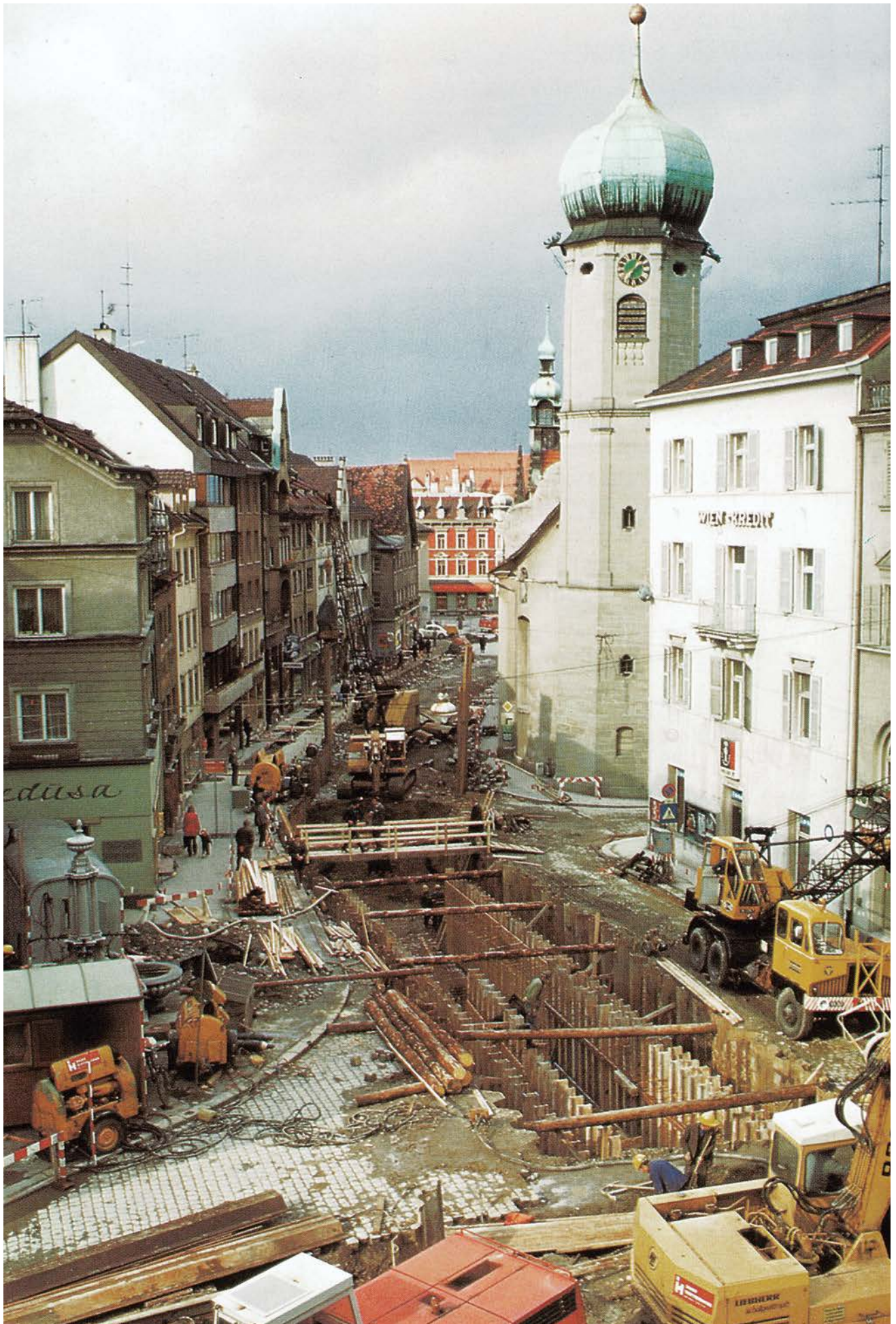
Kanalisierungsmaßnahmen und Thalbachverrohrung in der Rathausstraße in Bregenz, 1970er Jahre
