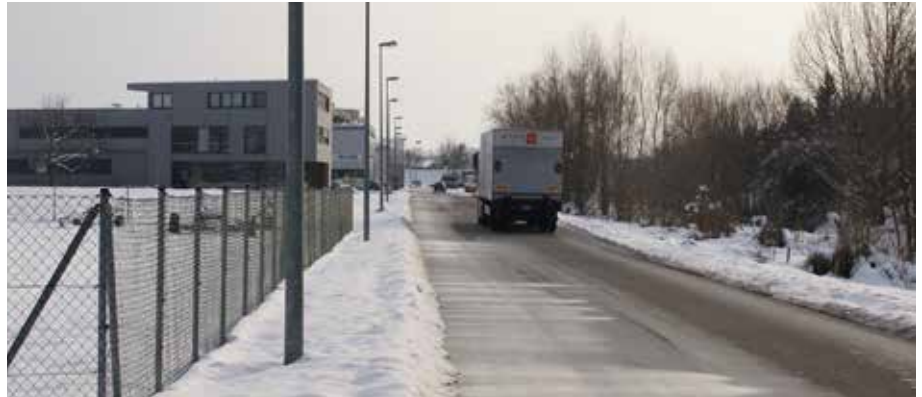
Die Industriestraße wird 2013 an die L 202 angeschlossen.
